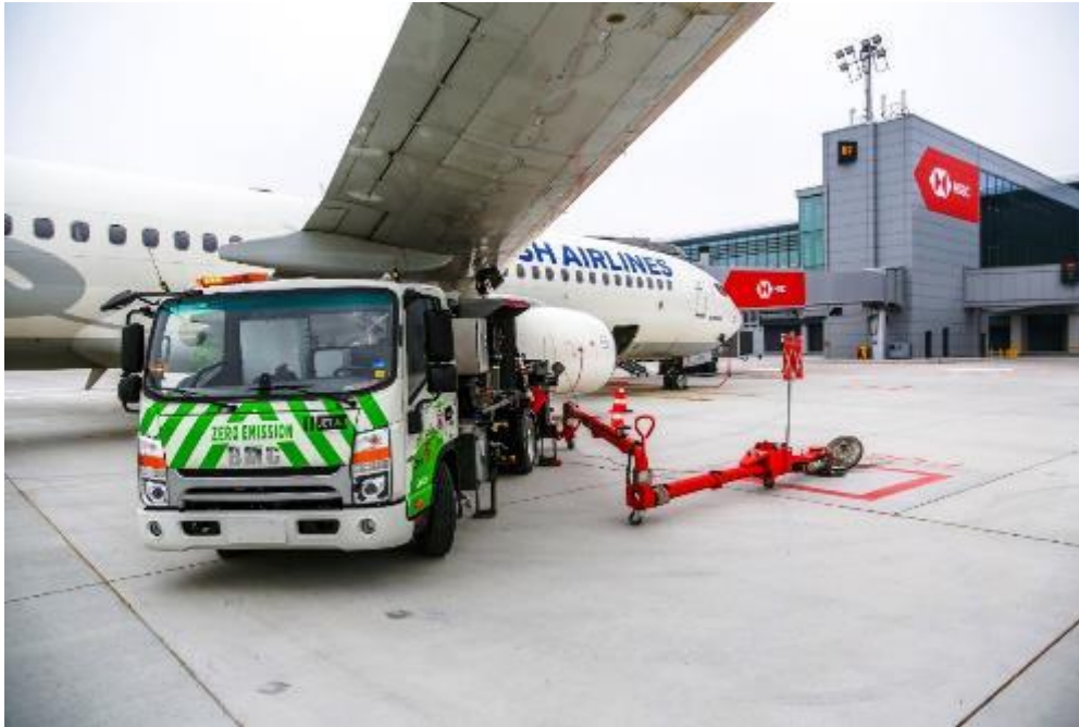
Yakıt Hidrant Sistemi
